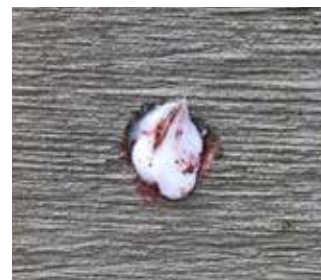
KÖSTER Crisin krema je čvrsta. Ovo je prednost pri radu s patronama i cjevastim vrećicama. Čak i kada se previše proizvoda nanese u bušotinu, višak materijala se neće slijevati na žbuku što može dovesti do tamnih mrlja. Višak materijala se može ukloniti, a bušotina naknadno ispuniti i ožbukati.
